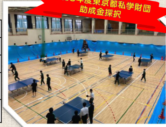
▲授業中、ブルーシート内で工事実施
