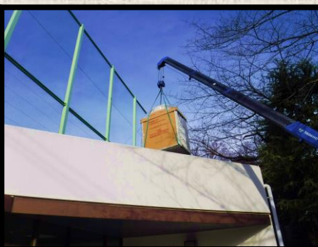
▲クレーン揚重作業
