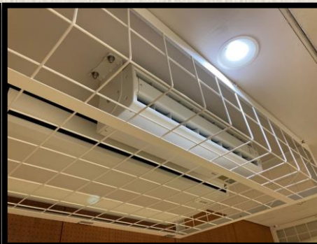
▲エア一搬送ファンによる 風量補助
