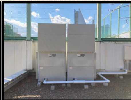
▲地域騒音規制対策の防音ダクト
